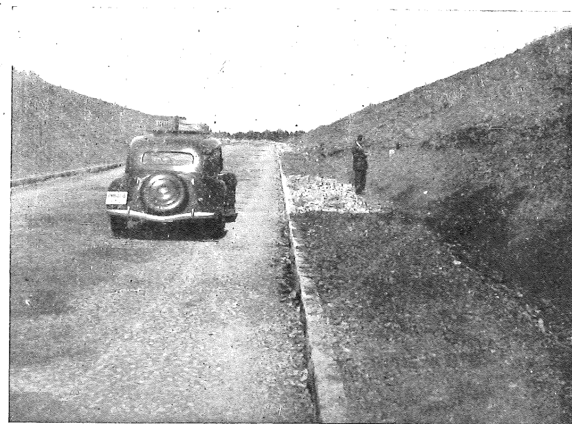
Fot. 2.—Arcillas, arenas y conglomerados rojos en la trinchera de la carretera de Madrid-Burgos, al N. de Fresno de la Fuente.
